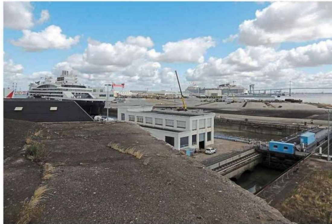
Le site de pré-assemblage servira à la préparation, au stockage et à l'assemblage d'éléments d'éoliennes
